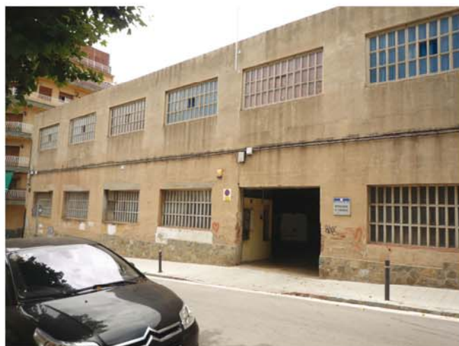
e 1.5* Brigada municipal d'obra
