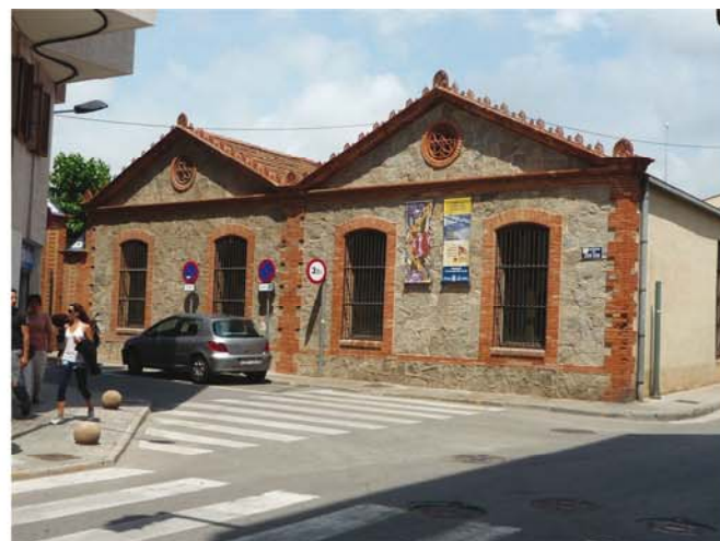
e 3.03 Fàbrica del Gas - Nau 2
