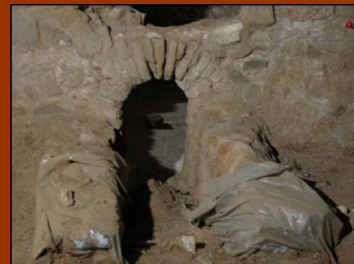
8. Degradació d'elements ceràmics.
