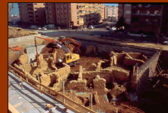
Construcció del recinte, al març de 2002.
