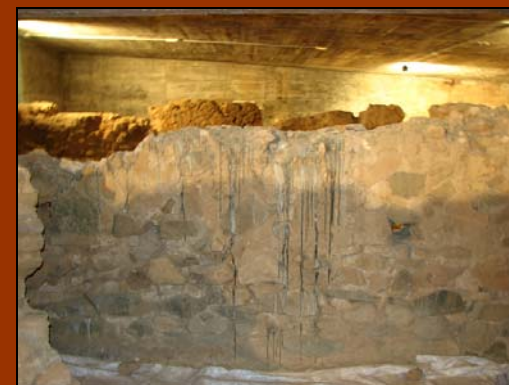
9. Presència de restes de ciment.
