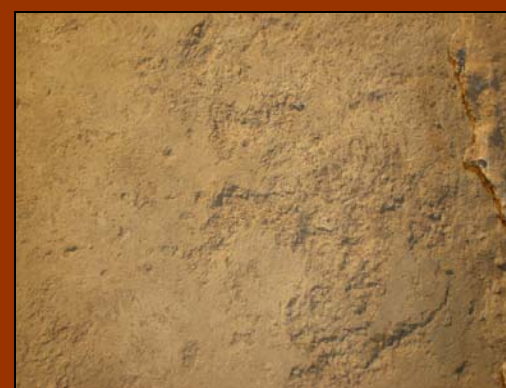
1. Concrecions calcàries i efluorescències salines.
