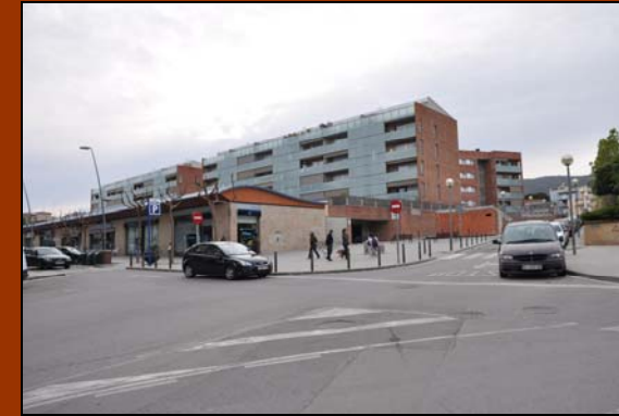
Vista general dels nous edificis de l'Horta Farrerons.
