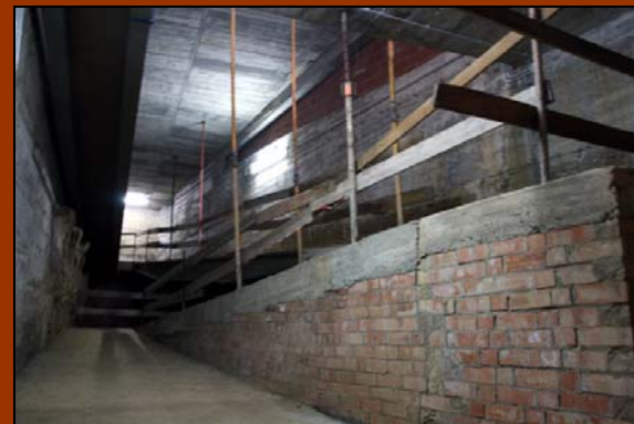
Rampa d'accés a la planta sotterrani.
