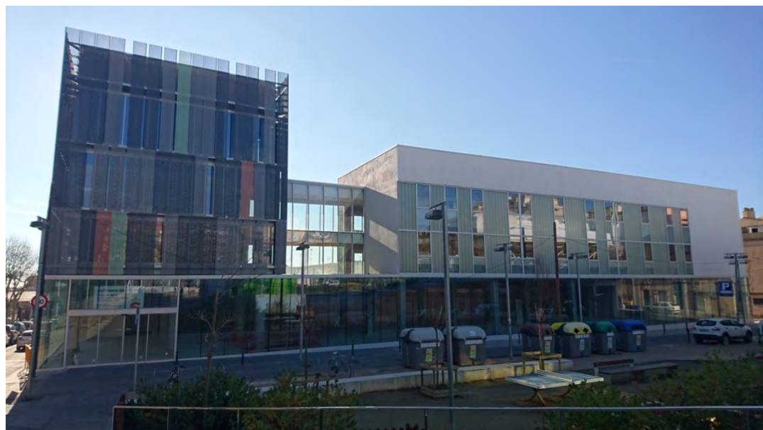
Façana carrer de la Unió
