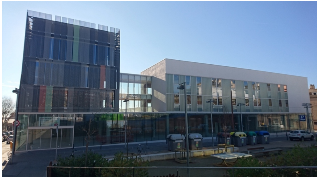
Façana carrer de la Unió
