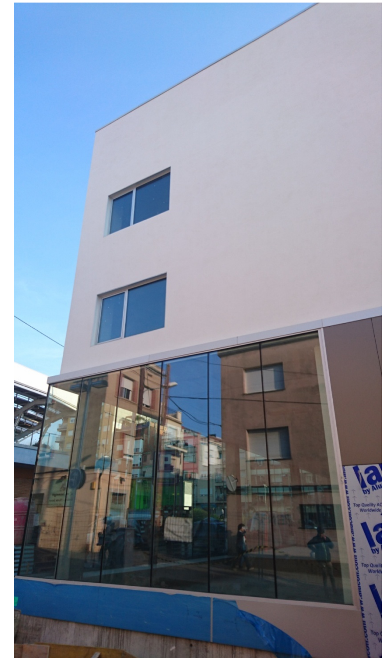
Façana carrer del Nord
