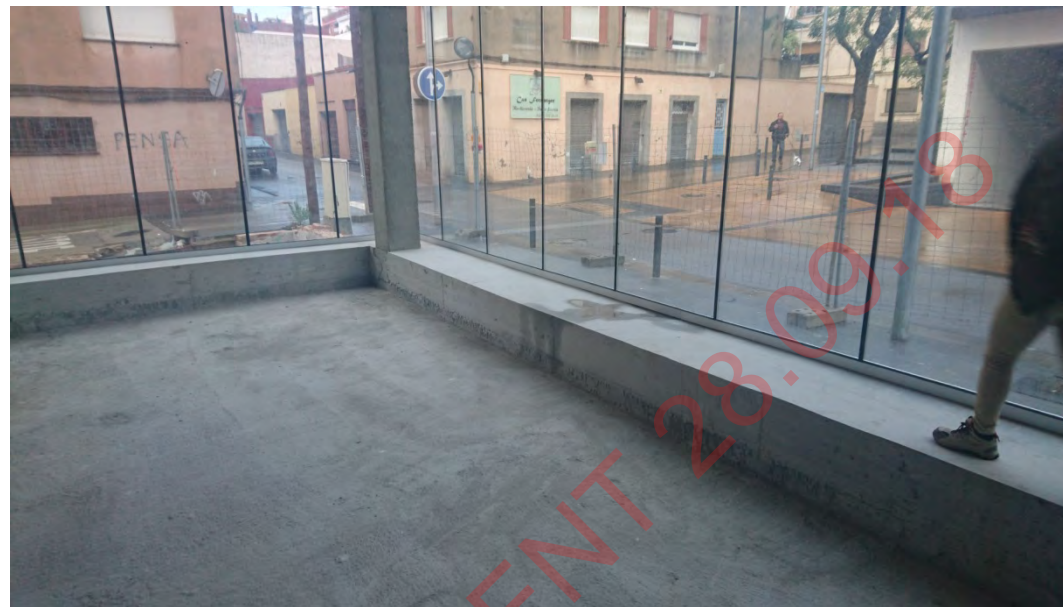
Estat actual de la zona del vestíbul
